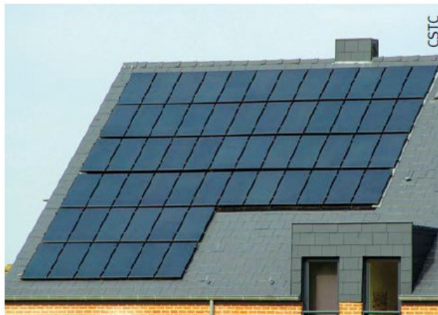
Fig. 10 Capteurs solaires photovoltaïques en semi-intégration.
