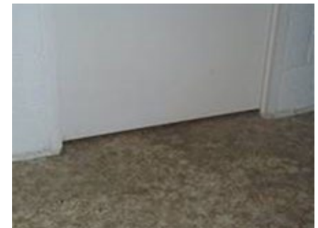
Ingekorte deur H_{\text{spleet}} \geq 5 \text{ mm}
