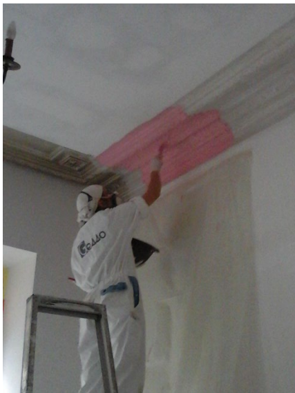
Het maken van een negatieve mal van de bestaande lijstwerk
