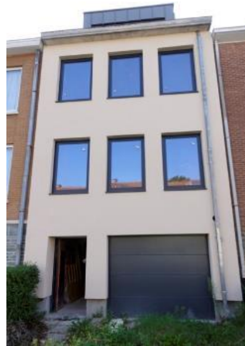
Voorgevel - NA Isolatie langs de buitenzijde
