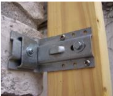
Metaal dat door de isolatie gaat
