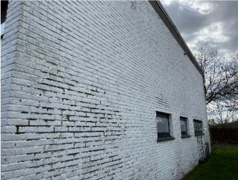
Geschilderd met afschilfering verf en algengroei
