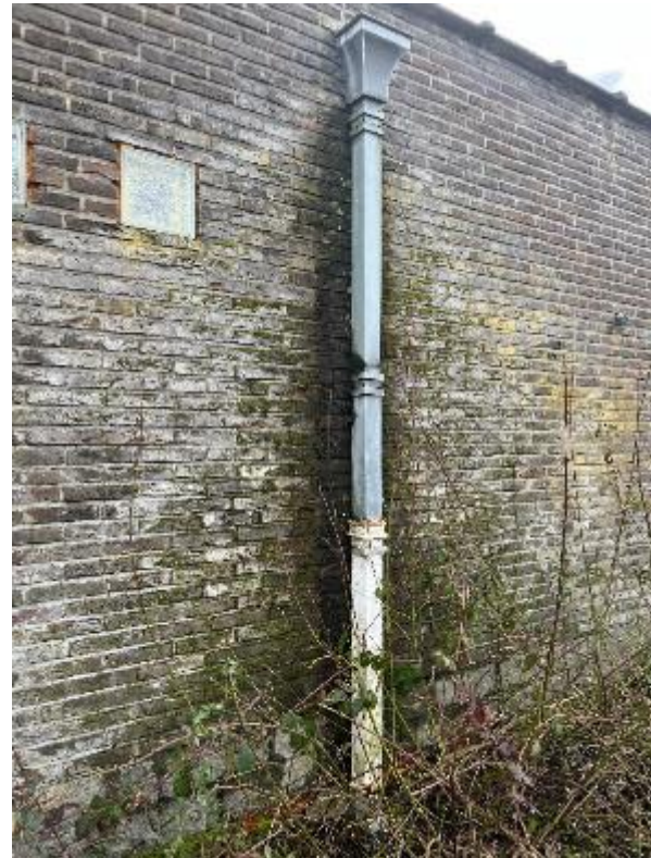
Lekkende regenwaterafvoer
