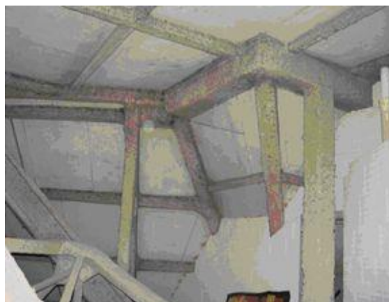
Sputasbest met amosiet (niet ingekapseld) op metalen steunbalken en isolerende platen van het type « Pical ».
