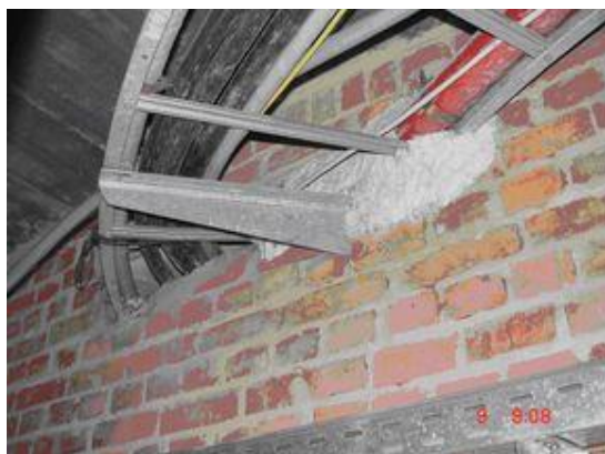
Sputasbest met amosiet (grijs) met een buitenlaag als inkapseling (dikke verf) op een metalen steunbalk met « I » vorm. Opvallend is het gerimpelde oppervlak.
