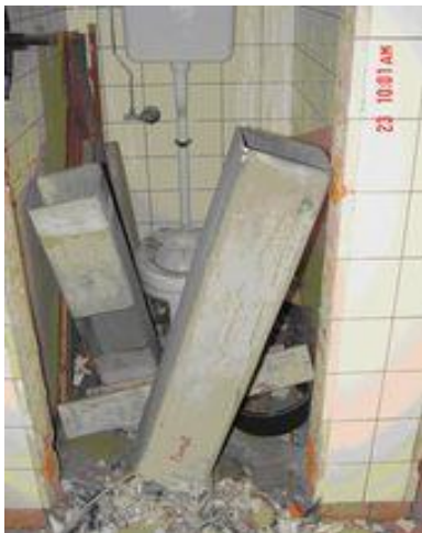
Verluchtingskokers in asbestcement (van sanitaire installaties)
