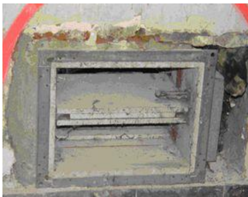
Brandwerende klep, aan de binnenkant met plaatmateriaal van het type 'Pical' bekleed. Het afsluitplaatje bestaat zelf ook uit dit plaatmateriaal.
