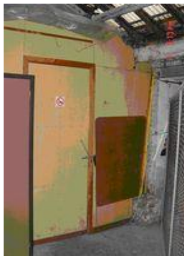
Wand bestaande uit dunne platen van het type 'menuisieriet'
