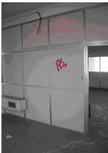
'Glasal' of 'Cloisal'-platen: binnenwanden van een kantoor
