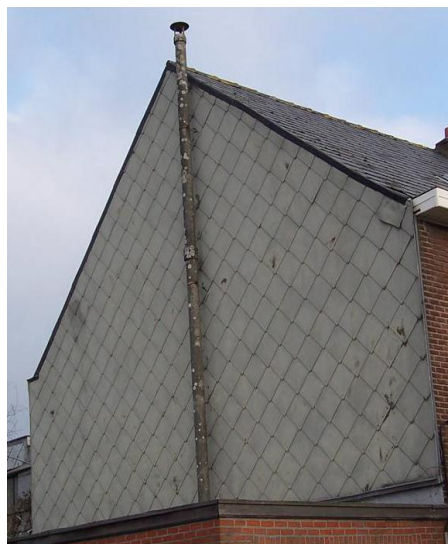
Dak, gevel en schouw in asbestcement
