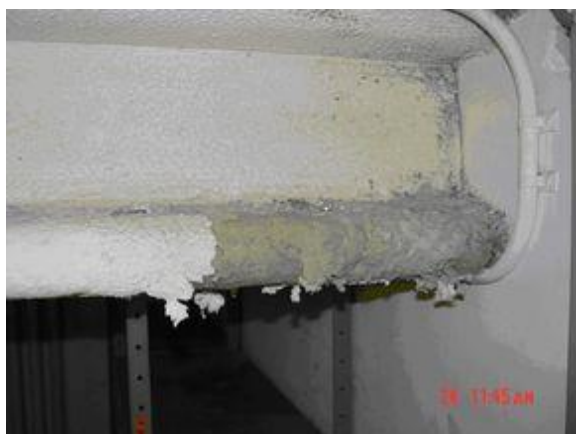
Sputasbest met amosiet (grijs) met een buitenlaag als inkapseling (dikke verf) op een metalen steunbalk met « I » vorm. Opvallend is het gerimpelde oppervlak.
