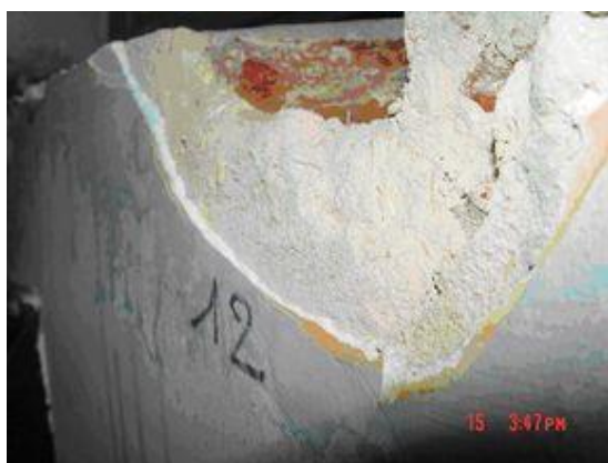
Dunne afwerkingslaag op muur in asbesthoudende pleister
