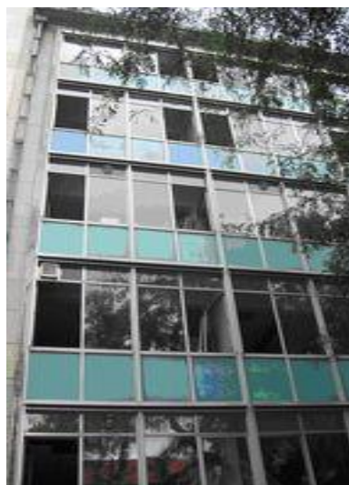
Panelen in asbestcement van het type 'Glasal' als steunmuur in een gevel (blauwgroene externe afwerkingslaag)
