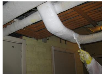
3. Een speciale verf aanbrengen op de stroken
