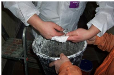
1. Voorbereiding van de pleisterstroken
