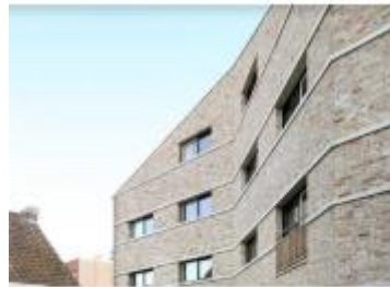
Façade de l'habitat groupé de Schilders
