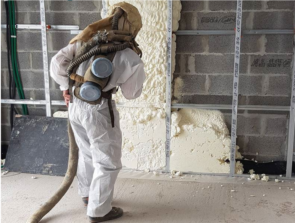
Integrale bescherming bij het spuiten van een warmte-isolerend materiaal
