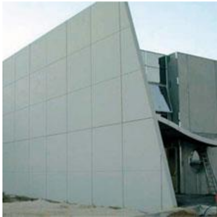
Dunne wand uit gewapend beton
