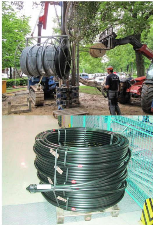
Forage & installation sonde PEHD
