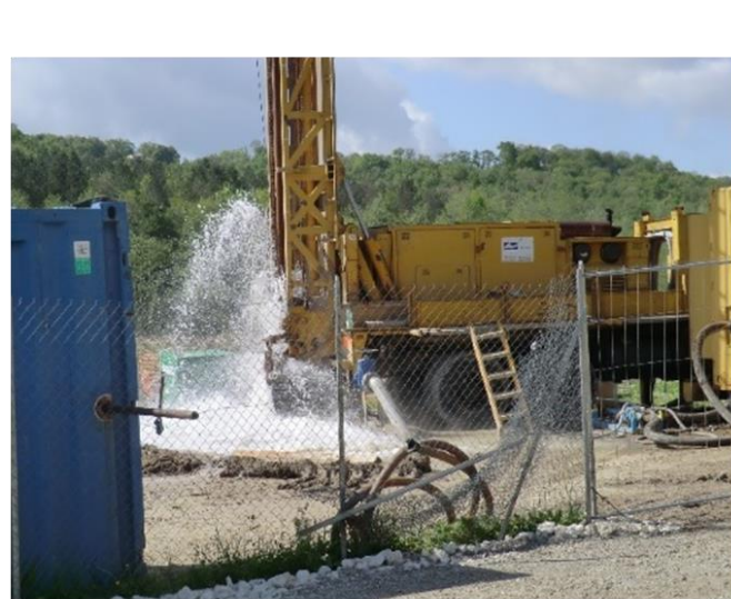
Forage du puits de production
