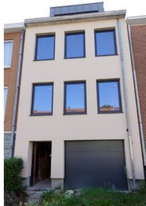
Voorgevel - NA Isolatie langs de buitenzijde
