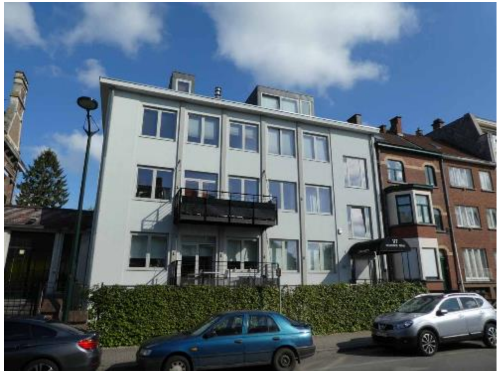
Voorgevel - NA Isolatie langs de buitenzijde
