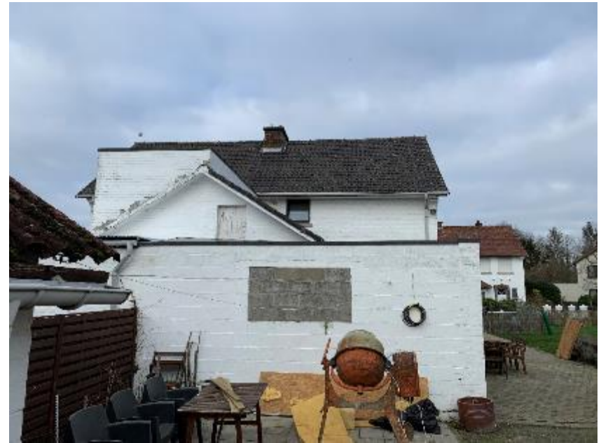
Geschilderd met afschilfering en aangebouwde delen
