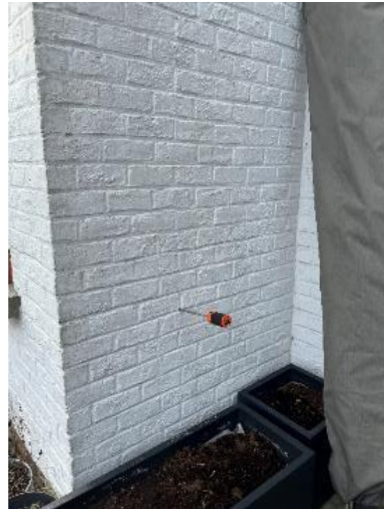
Geschilderde gevelsteen met dampdichte verf
