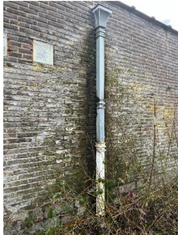
Lekkende regenwaterafvoer
