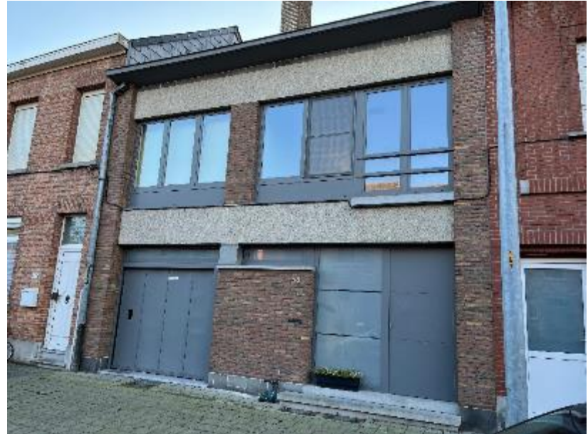
Gevel met (bijna) geen spouwmuren
