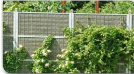
Clôture anti-bruit composée d'acier, de fibre laine de roche (matériau acoustique de base) et d'un filet de polythène vert
