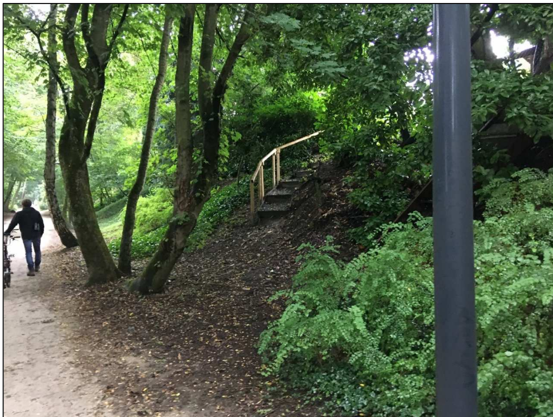
Foto 3: Trapconstructie naar aanpalende woning
