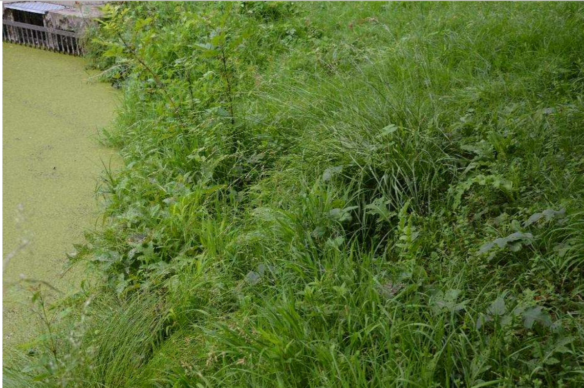
IB8_05. Monnik (bouwjaar 2009), overloop naar Mellaertsvijvers aan uiteinde westelijke vijver met vochtige boszoom, ruigte op de oever. Hogerop is 6510 glanshavergrasland gekarteerd.
