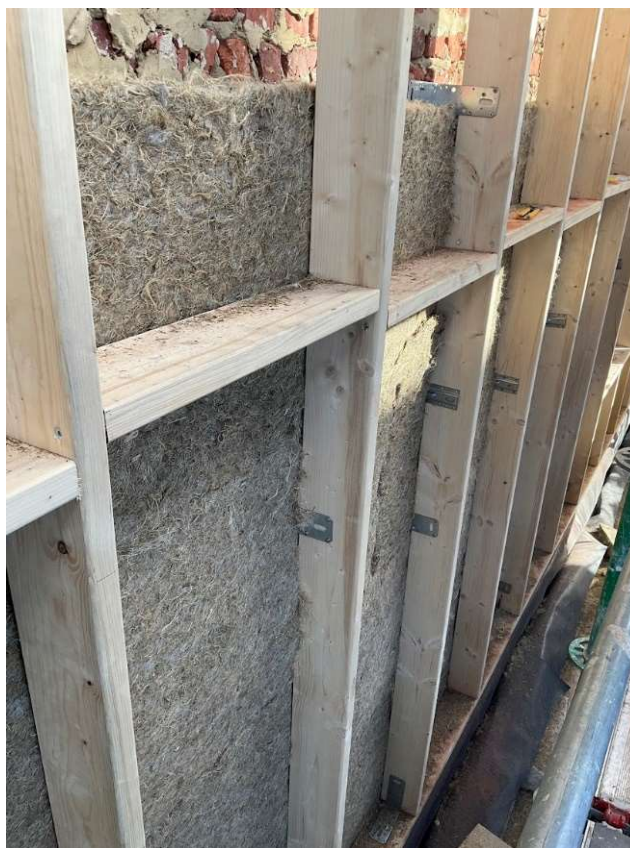
1e doorlopende laag niet-doorlopende bevestiging
