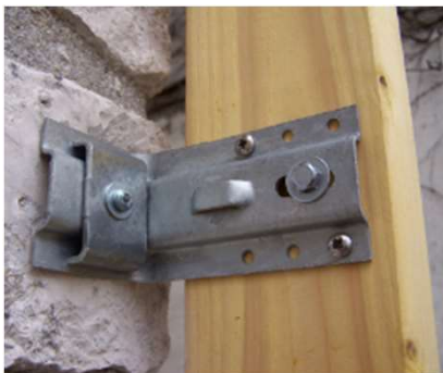
Metaal dat door de isolatie gaat
