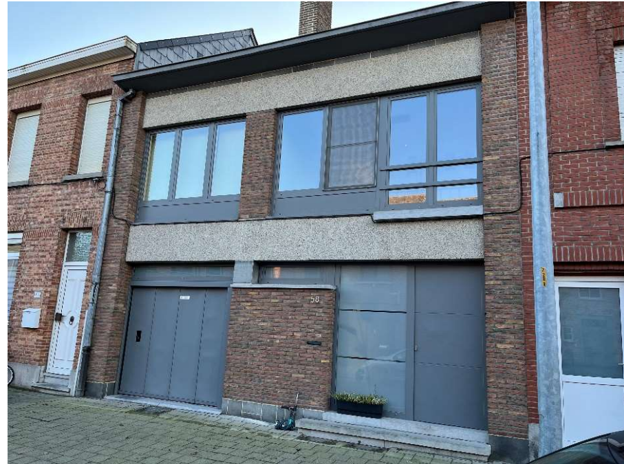
Gevel met (bijna) geen spouwmuren
