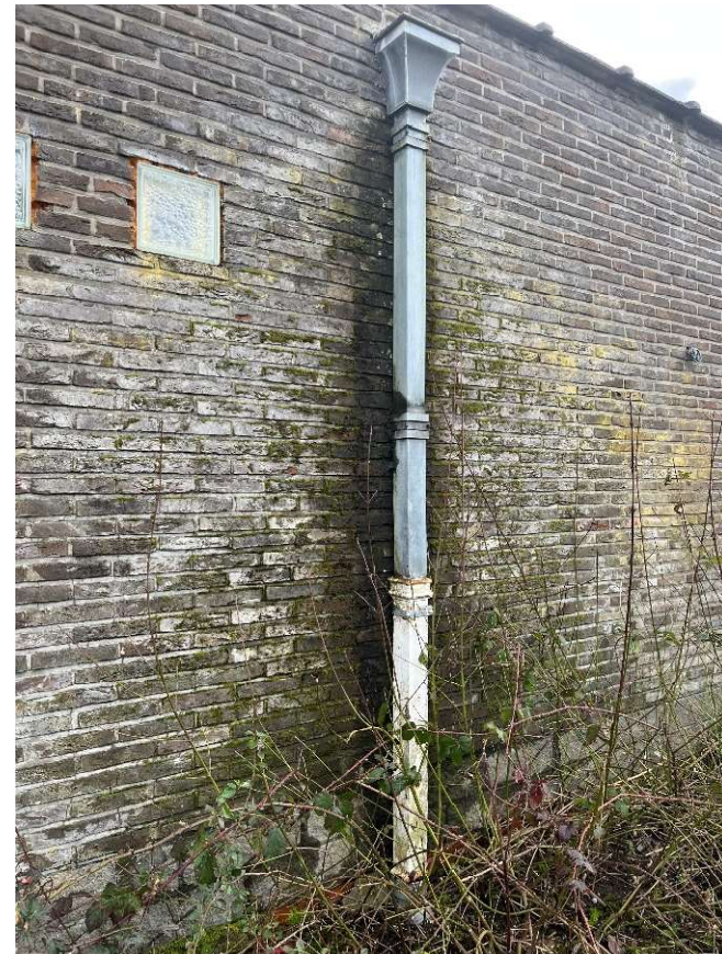
Lekkende regenwaterafvoer
