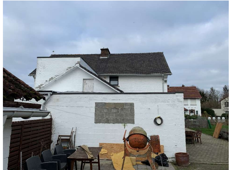
Geschilderd met afschilfering en aangebouwde delen
