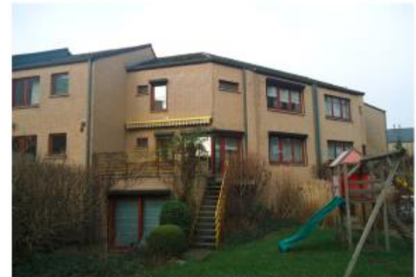
Vue arrière de la maison, à l'emplacement de la future annexe
