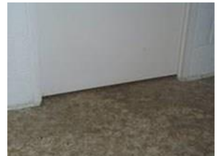
Ingekorte deur H_{\text{spleet}} \geq 5 \text{ mm}
