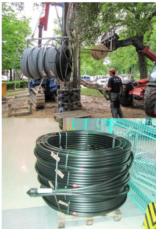
Forage & installation sonde PEHD
