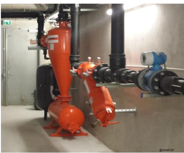
Filtre cyclonique et tamis (50 m 3 /h)
