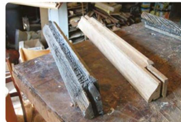
Reproduction à l'identique d'une pièce (jet d'eau) à remplacer
