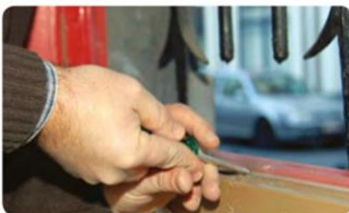
Débouchage des trous d'évacuation du bas du châssis
