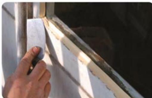
Remplacement d'un mastic endommagé
