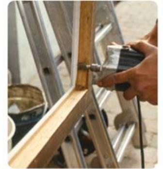
Pose de double vitrage avec élargissement de la feuillure à vitrage
