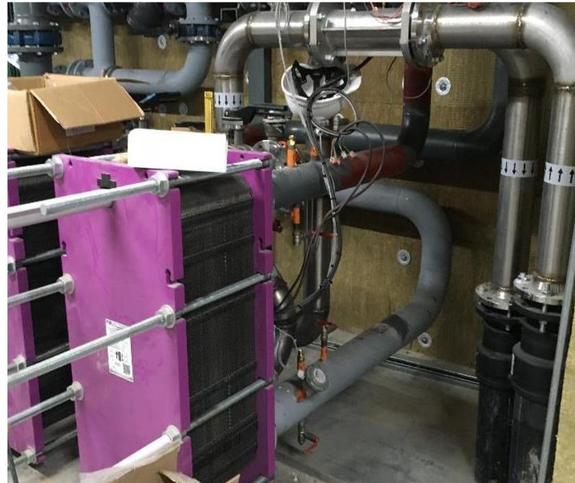
**Echangeur à plaques géothermique**
