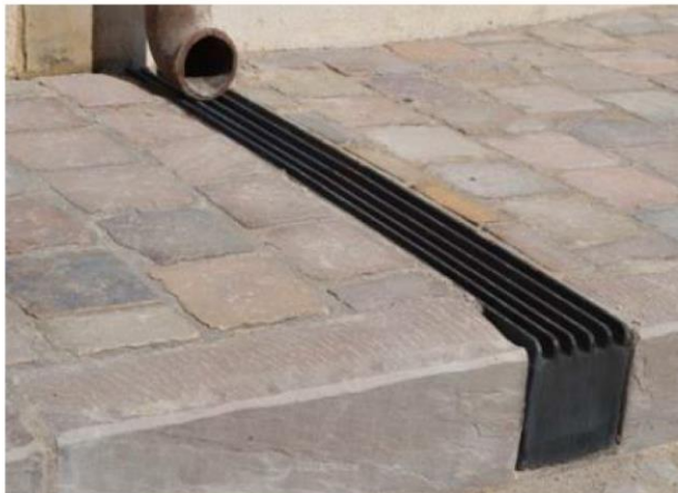
Exemple de mise en œuvre – Descente de gouttière avec finition bordure et Quai portuaire à Rostock Source : HYDROTEC©
