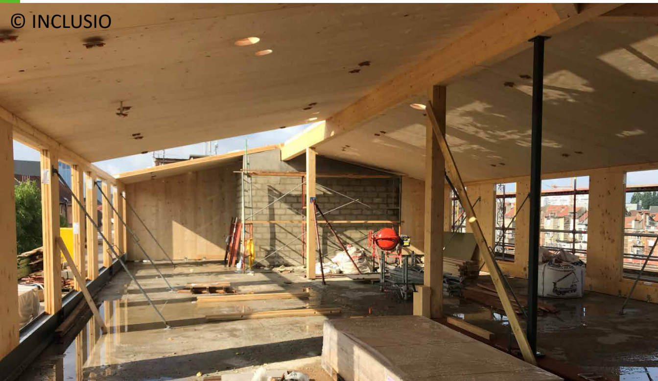
Houten structuur (CLT) op de 4de verdieping
