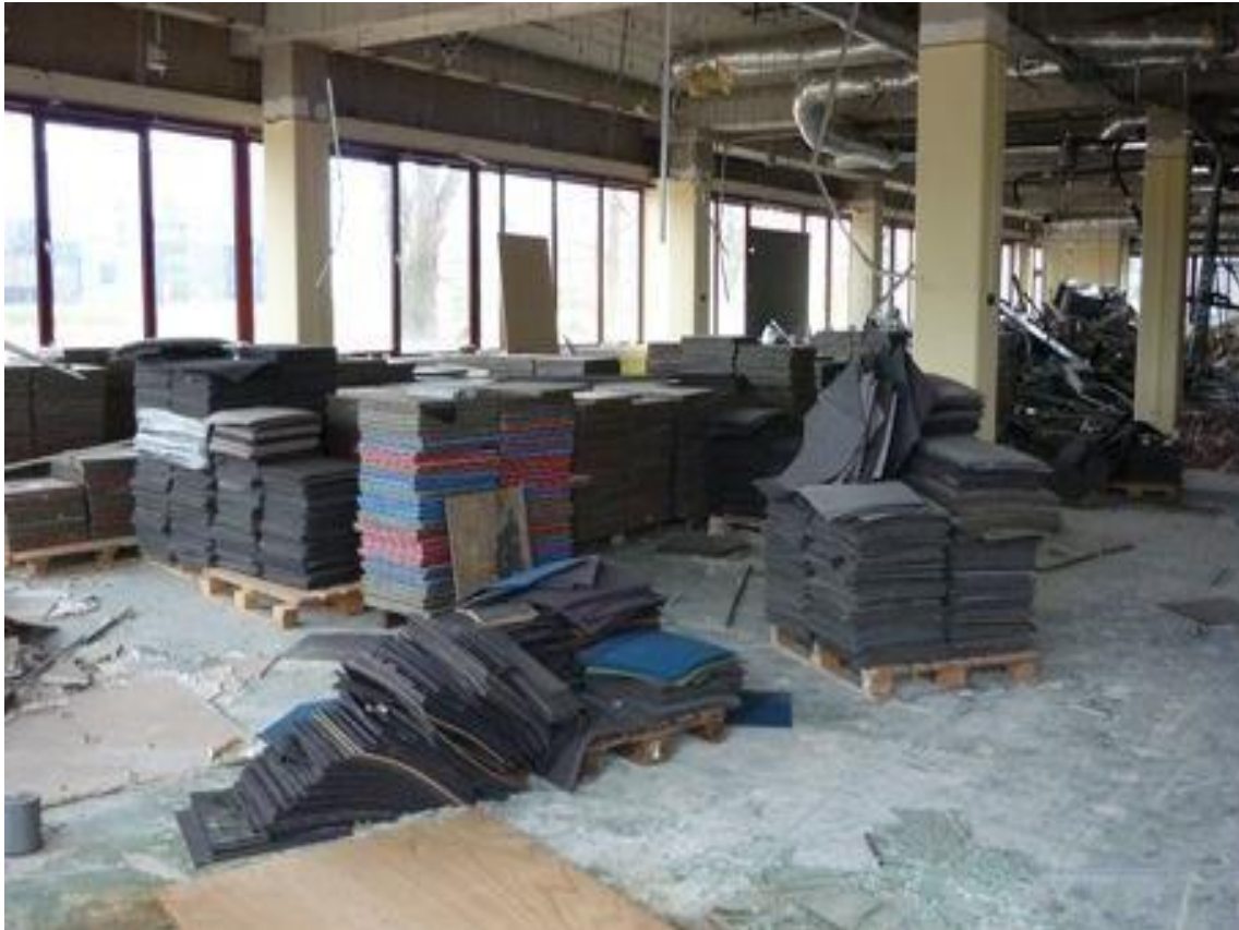
Demontage van afbouwmaterialen van een kantoorgebouw Bron: cera|a| asbl
